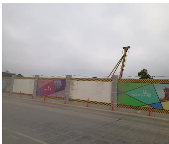
热网工程临时拦挡
