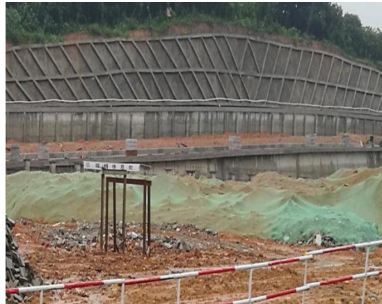
厂区临时堆土密目网苫盖
