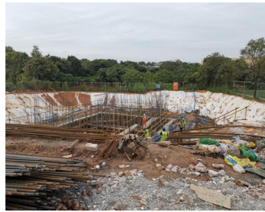
取水泵房开挖基坑边坡临时苫盖
