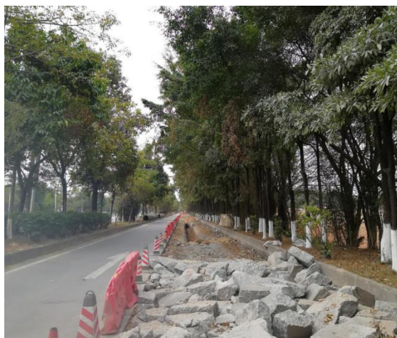
热网工程硬化路面破碎
