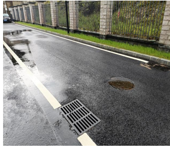
厂区路面硬化及雨水管网
