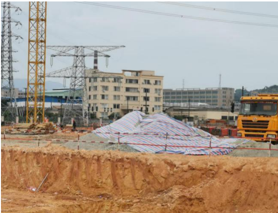
厂区临时堆料密目网苫盖
