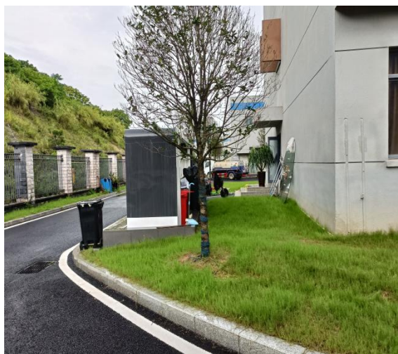
供水管线及取水泵房绿化
