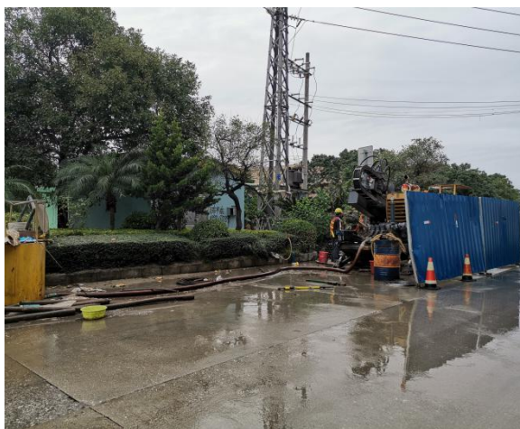
供水管线顶管施工
