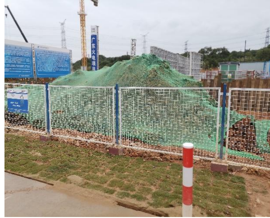
厂区临时堆土密目网苫盖
